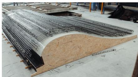
Für den Bau der Welle wurde u.a. Carbon-Recyclingbeton eingesetzt.
